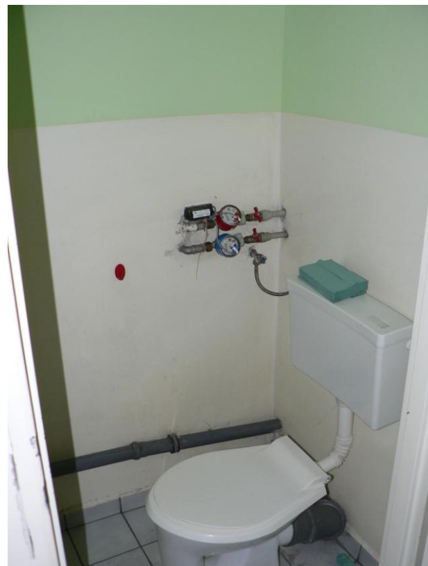
Fot.3. Pomieszczenie W.C. – wodomierze wody zimnej i ciepłej.
