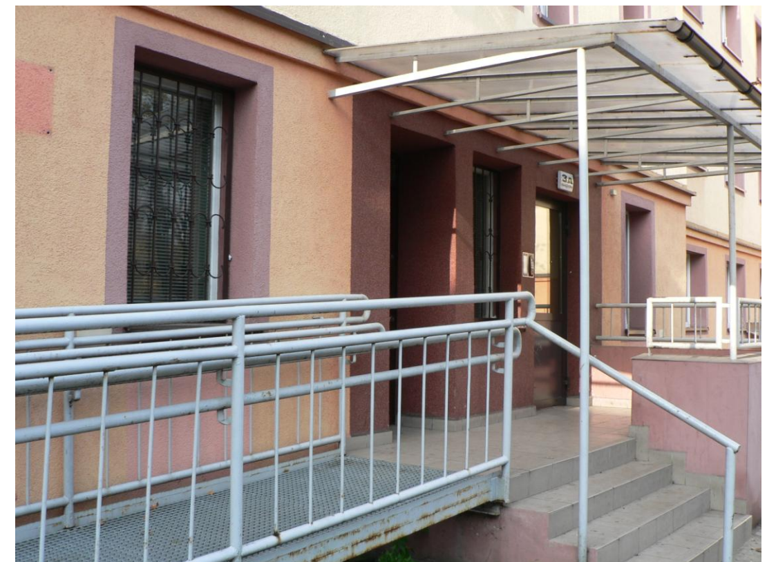
Fot.8. Elewacja północno-wschodnia – istniejąca pochylnia dla osób niepełnosprawnych oraz główne schody wejściowe do budynku.
