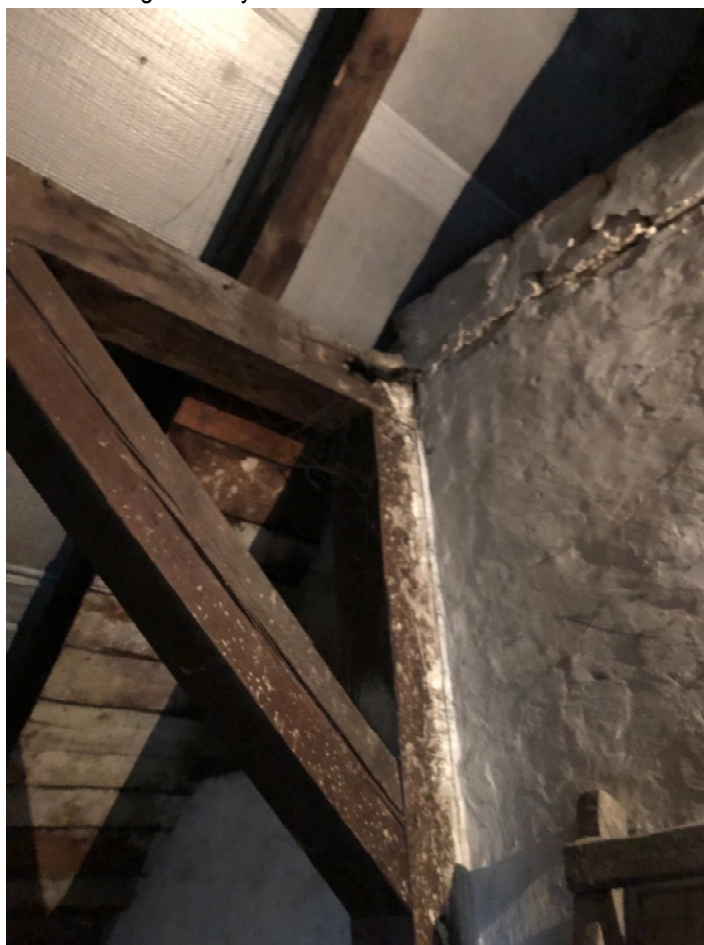
Widok na załamanie wysokości połąć dachu i strop nad mieszkaniem – fragment ściany widoczny od strony strychu od zewnątrz mieszkania
