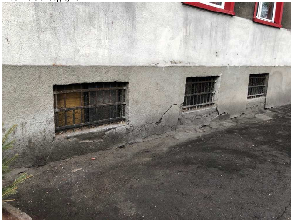
Widok na spękania cokołu i trzy okna do pomniejszenia
