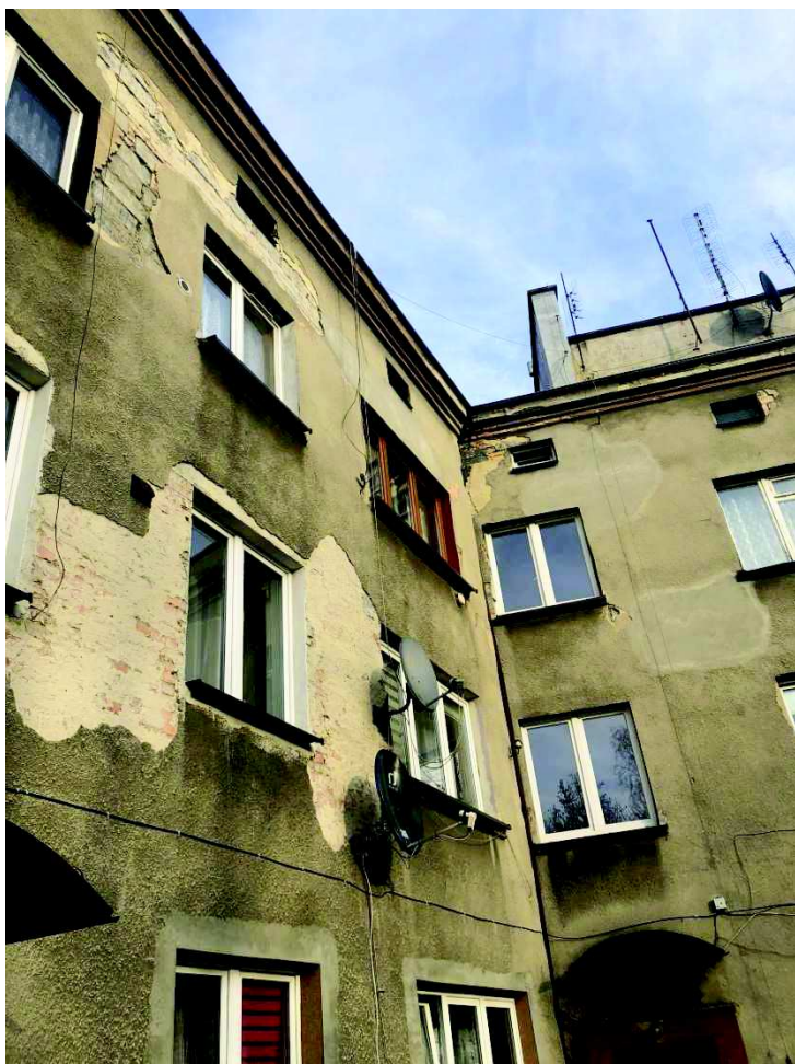
Widok na odspojenia tynku na elewacji
