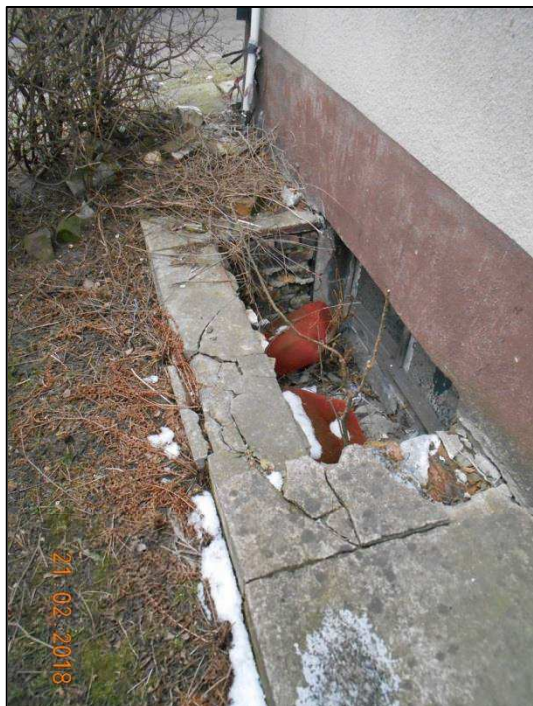
Uszkodzona studnia okienka piwnicznego oraz opaska betonowa – elewacja zachodnia
