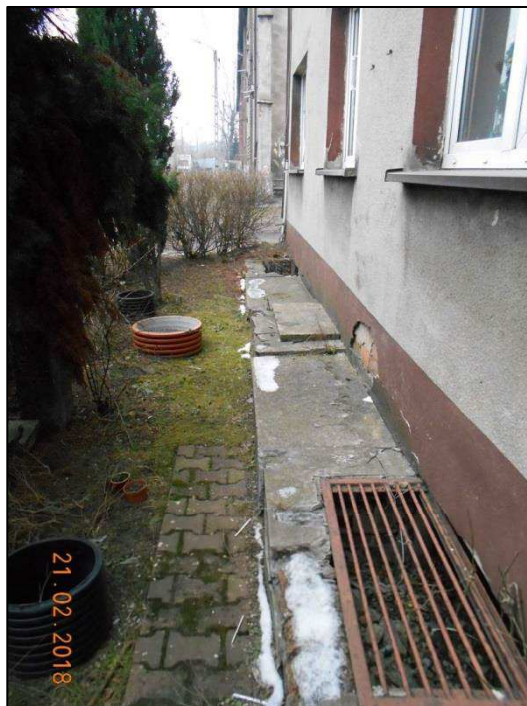
Uszkodzona studnia okienka piwnicznego oraz opaska betonowa – elewacja zachodnia
