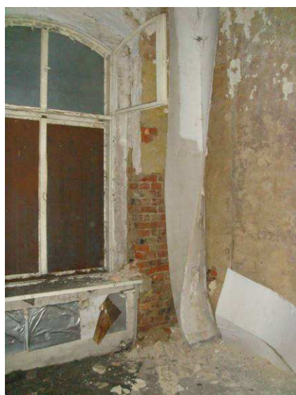
Rys. 12 – Zawilgocenie ścian parteru
