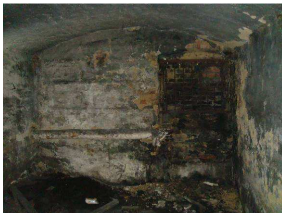
Rys. 9 – Zawilgocenie i grzyb otynkowanych ścian piwnic
