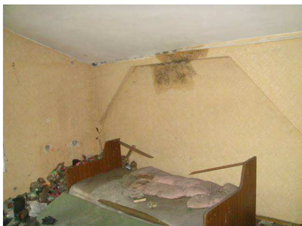
Rys. 20 – Widoczne zawilgocenie na tynku wykonanym na trzcinie
