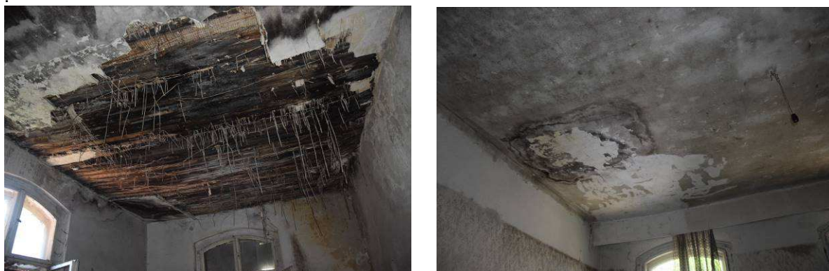
Rys. 17 – Widoczne w zawilgocenie i uszkodzenia stropu nad parterem
