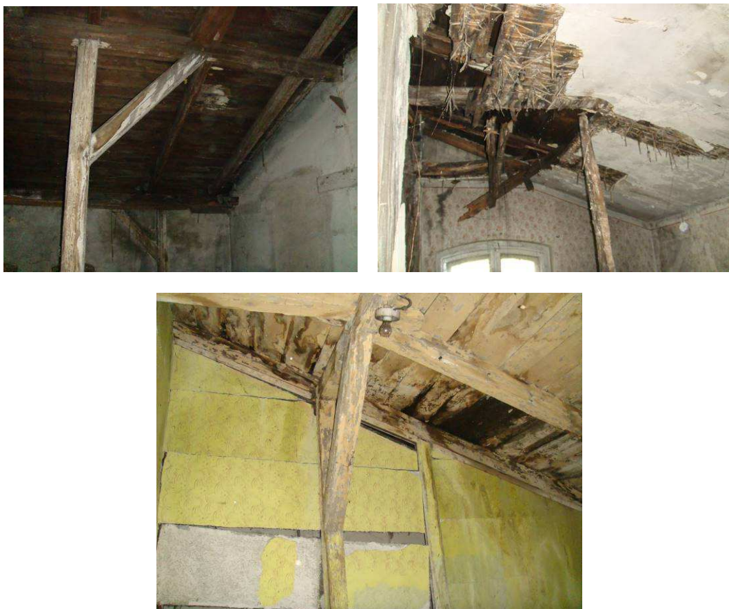
Rys. 19 – Widoczne zawilgocenie i zniszczenie konstrukcji dachu
