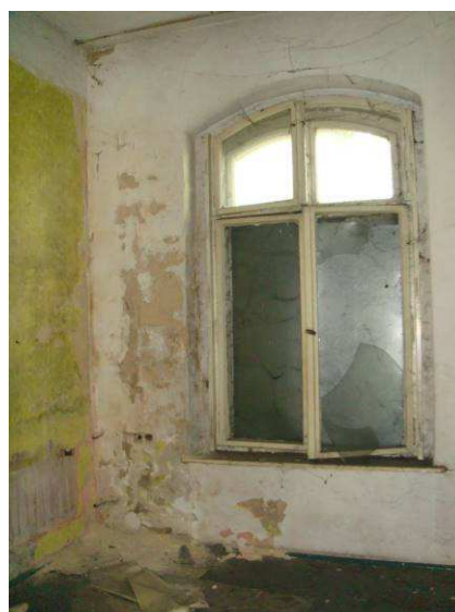
Rys. 12 – Zawilgocenie ścian parteru
