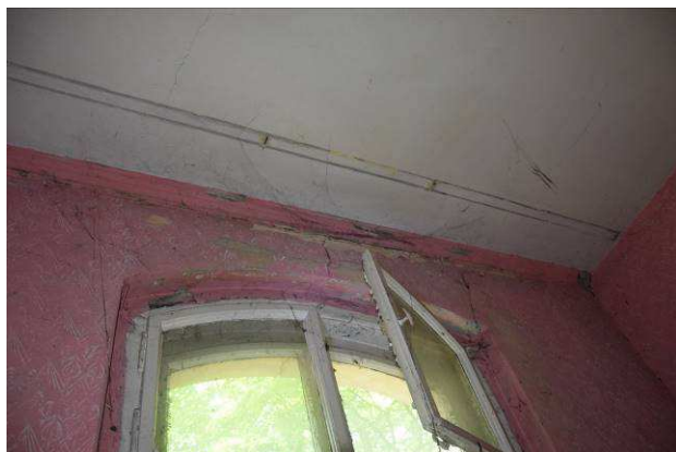
Rys. 14 – Rysy i spękania nadproży i podokienników
