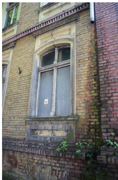
Rys. 14 – Rysy i spękania nadproży i podokienników
