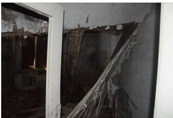
Rys. 18 – Widoczny zarwany strop nad I piętem
