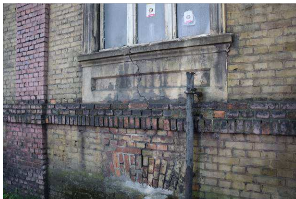
Rys. 11 – Spękania i rysy nadproży okien piwnic
