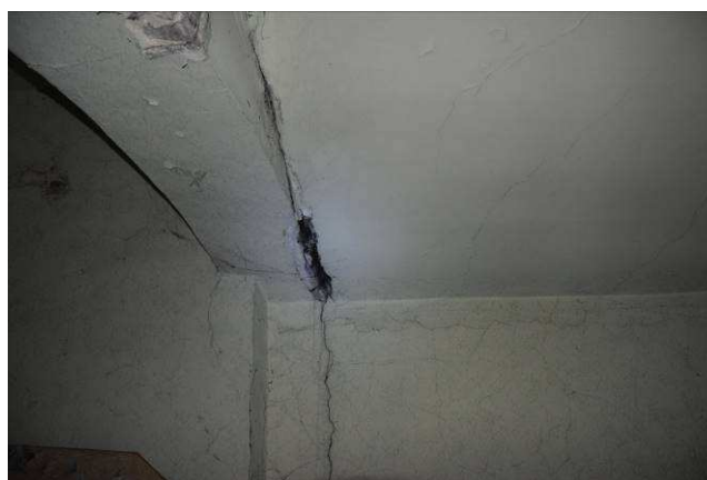
Rys. 13 – Rysy wskazujące na odchylenie od głównej bryły bud. jednej z dobudówek
