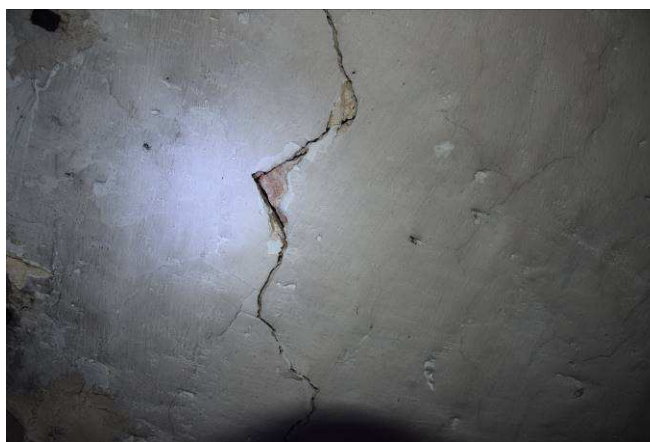
Rys. 15 – Spękanie w szczycie łuku w pom. północno – wschodnim
