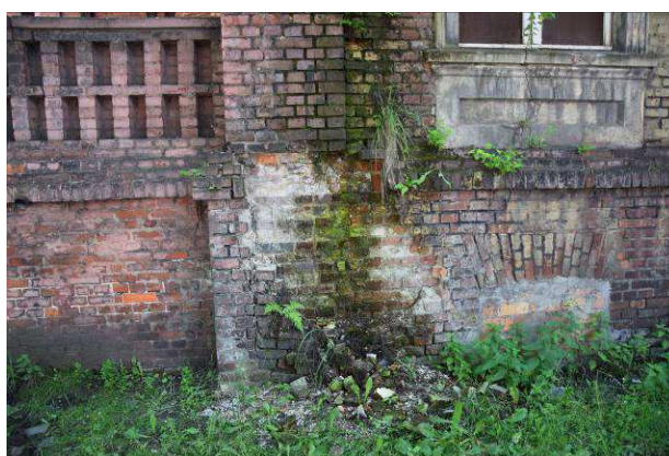
Rys. 10 – Ubytki cegły w narożniku głównej bryły budynku
