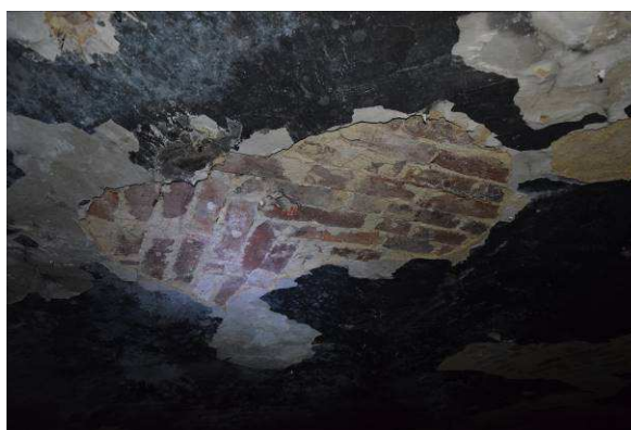
Rys. 16 – Widoczne w pozostałych pomieszczeniach sklepienia łukowe w relatywnie dobrym stanie
